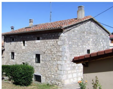
Fachada lateral y trasera
