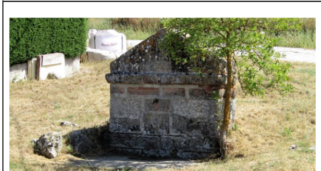
Vista frontis, suelo del pilón
