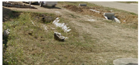
Restos del vaso existentes y tubo entrada desde fuente
