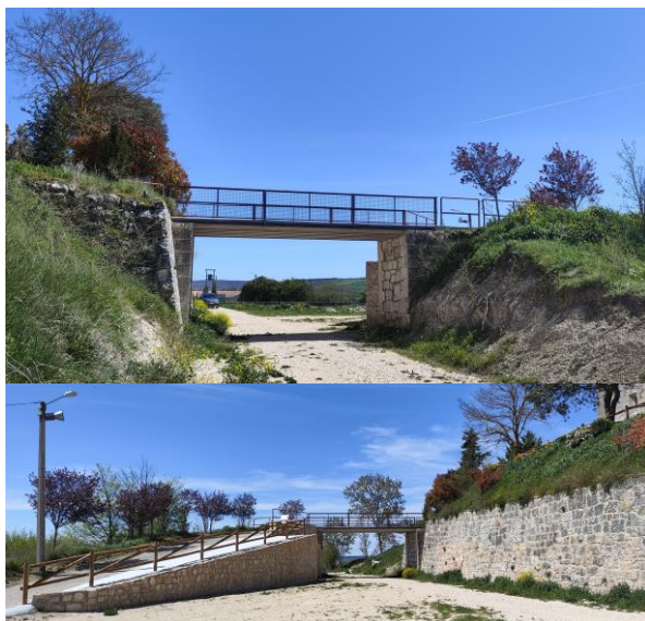
Vista entorno y puente
