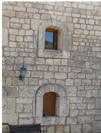
Detalle recerco huecos
