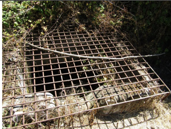
Recerco cantería y cierre proteccion
