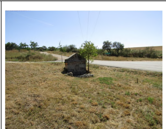
Vista en paraje restos del pilón
